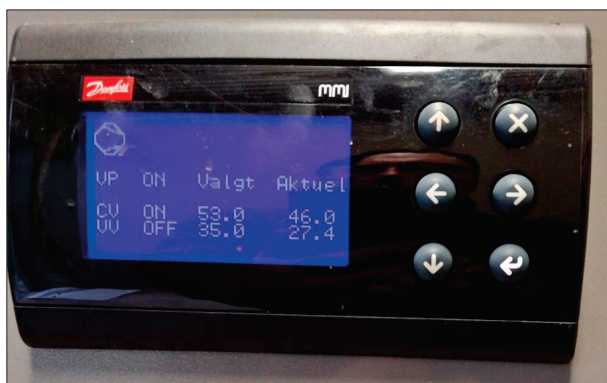
Figur 2: TV ses den nuværende styringsenhed fra Danfoss, og til højre ses producenten af varmepumpen (model GeoNova 42). Varmepumpen har en SCOP på 4,34 (der er gulvarme).
